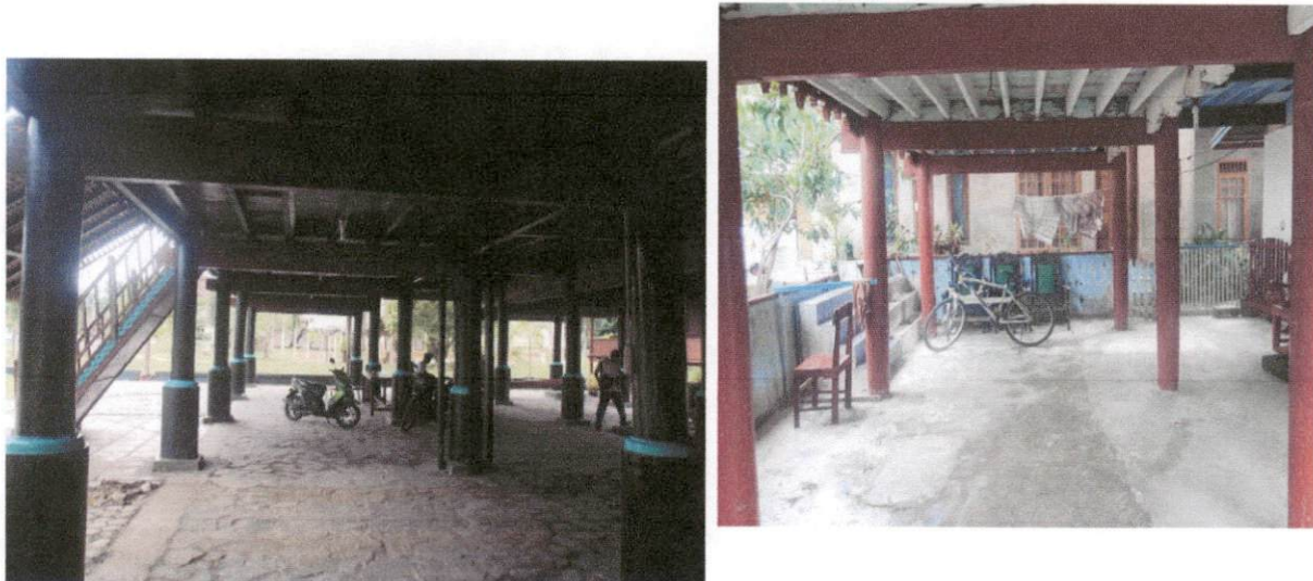
Gambar 1 : Panggung atau Kolong pada Rumoh Aceh di Pidie Jaya
