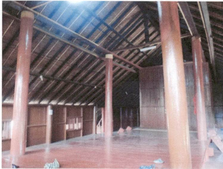
Gambar 9: Tiang pada Rumoh Aceh
